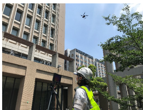
ドローンによる外壁タイル1次調査状況
